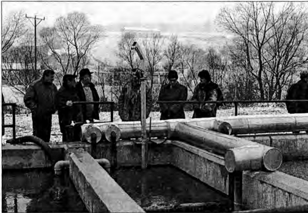
Kontrola birczańskiej oczyszczalni ścieków przez państwowego inspektora pracy.
