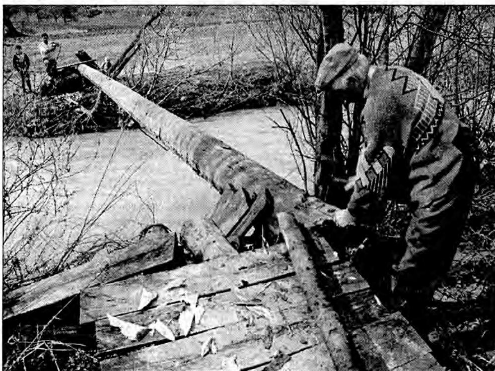
Sąsiedzi Krug i Teleśnicki przy budowie prowizorycznej kładki.
