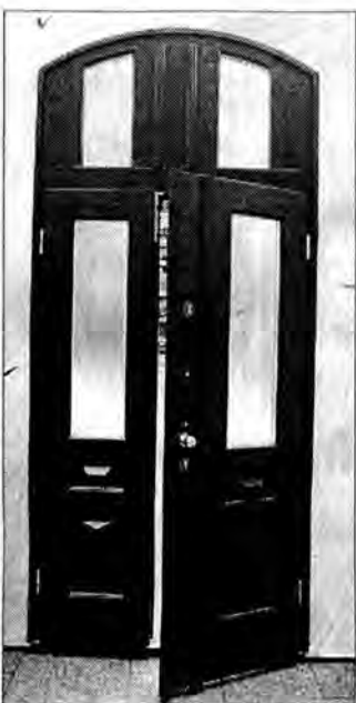
Jeśli w drzwiach są elementy szklane, muszą to być szyby antywłamaniowe.
