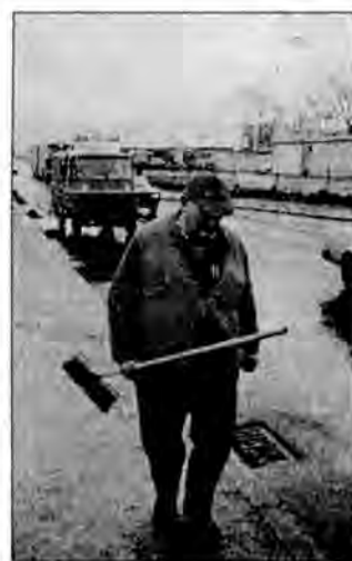
Służby drogowe pracują...
