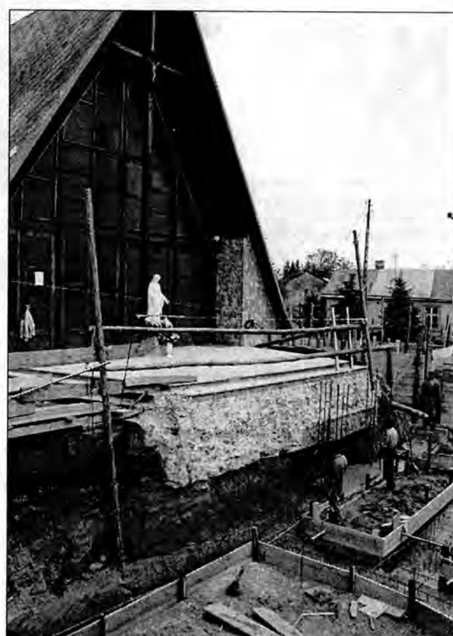
Fundamenty pod nowy kościół.
