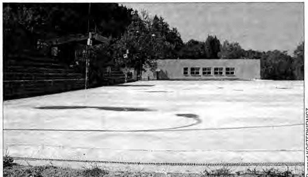
Sztuczne lodowisko w Przemyślu – stan kończący pierwszy etap modernizacji.
