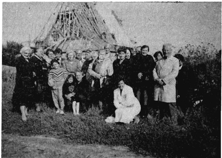
Z wizytą w Strzelczyskach (w tle budowa kościoła).
