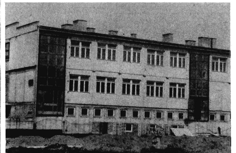
Szkola w budowie.
