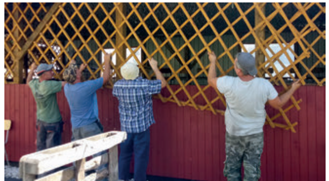
Zakładanie nowej kratownicy
