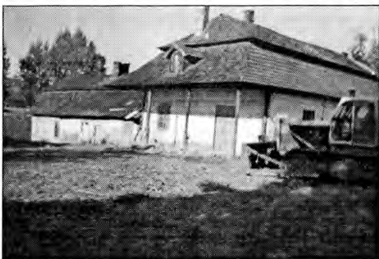
Do prac porządkowych niezbędny był spychacz
