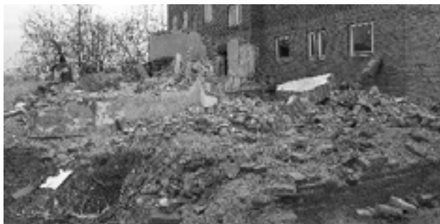
1 II 2008 r. - rozbiórka starej szkoły w Sadkowej Górze (fot. W. Gąsiewski)
