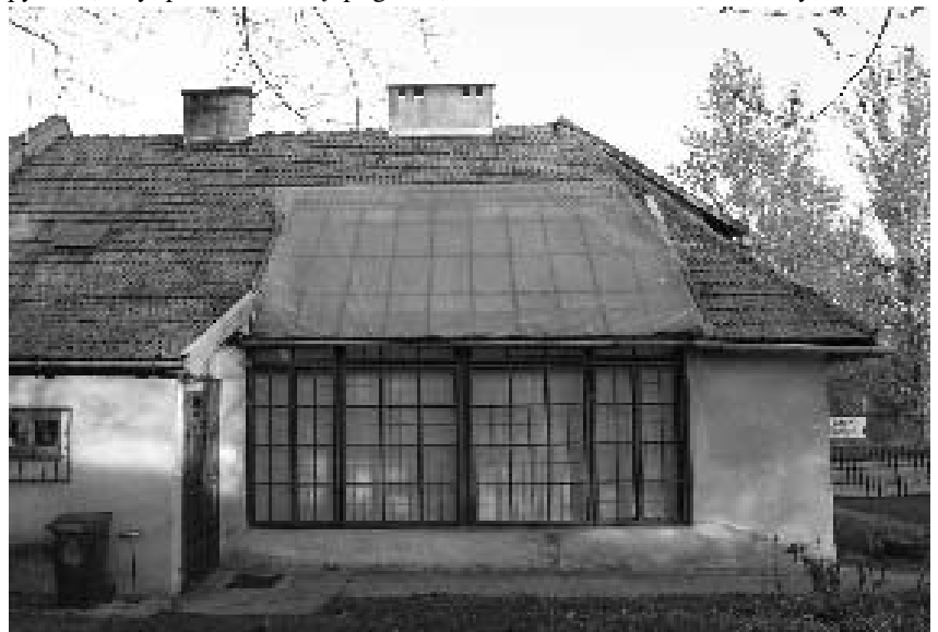
Widok na atelier fotograficzne Jadernych. Szklany dach został przykryty folią.
