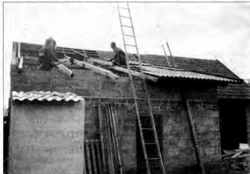
Poszkodowani zaczęli od odbudowy dachów.
