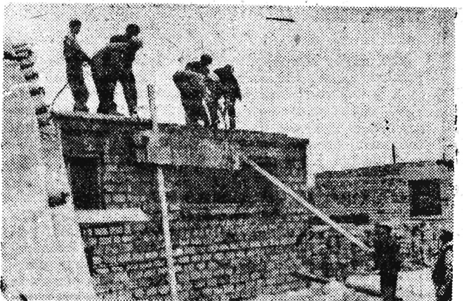
Budowa stołówki dla robotników pracujących przy budowie kombinatu siarkowego w Machowie.
