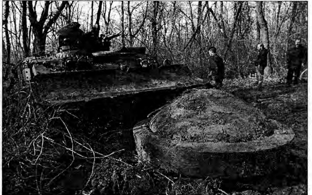
Potężny ciągnik gąsienicowy WZT-2 uporał się z wyciągnięciem kopuły.
