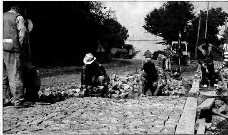
Ręczne układanie kostki na ulicy Przemysława.
