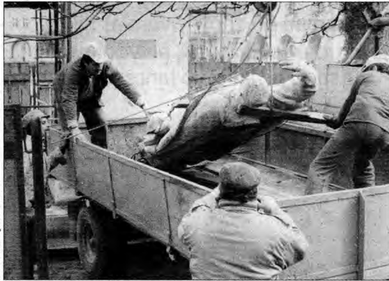
Demontaż pomnika Wdzięczności Armii Radzieckiej.
