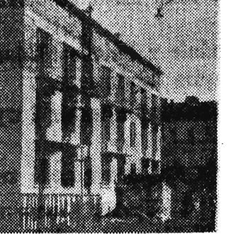
Blok mieszkalny budowany w Jarosławiu z funduszy Rzeszowskiej Gry Liczbowej
