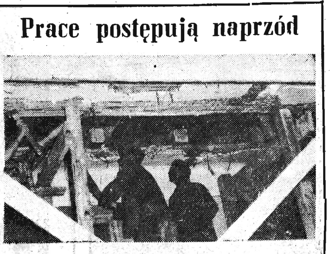
Adaptacja przyszelego Domu Handlowego „Delikatesy” pomimo dużych trudności przebiega pomyślnie
