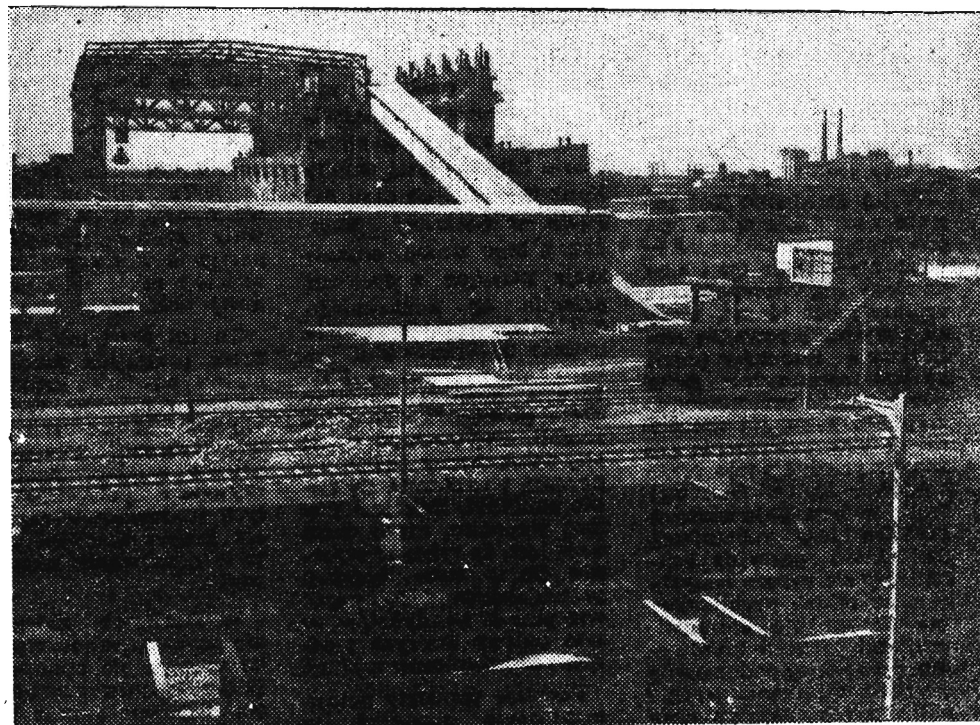
Na zdjęciu: Ogólny widok cemenłowni w Nowej Hucie.
