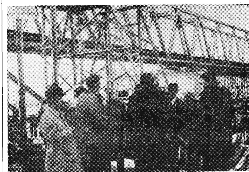
Goście radzieccy na budowie mostu w Nagnajowie.
