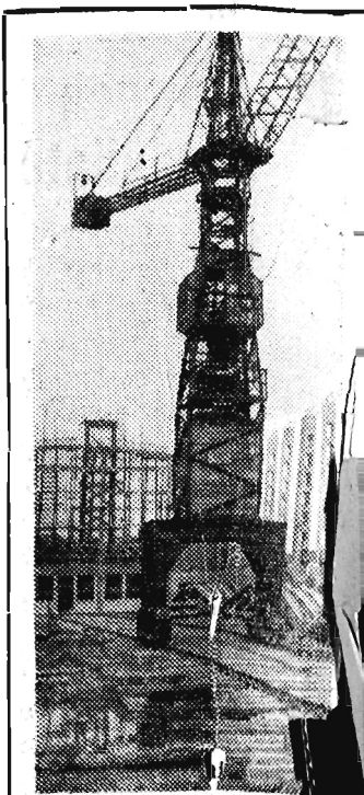
Huta Szkła Gospodarczego w Krośnie poza ogólną modernizacją zakładu buduje nowy oddział „Krosno II”, w którym produkcja ruszy w 1961 r. Huta Szklana Techniczna „Polanka” jest również w rozbudowie. Na zdjęciu: Fragment budowy nowej hali w hucie „Polanka”.
