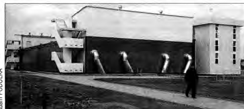
Od 11 maja w Zakładzie Uzdatniania Wody w Przemysłu woda z Sanu poddawana jest procesowi ozonowania.
