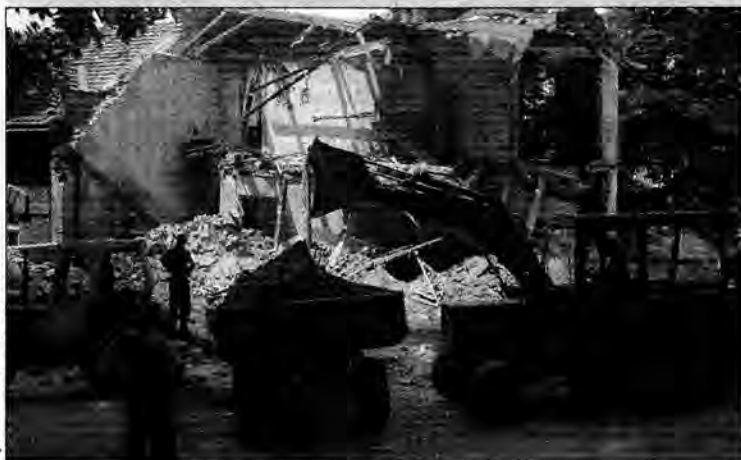
Rozbiórka rudery przy ul. Parkowej.
