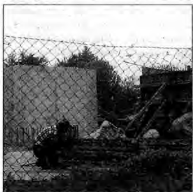
Prace nad fundamentami.
