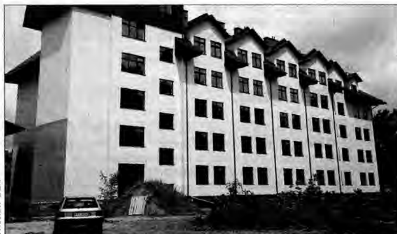
Podpis pod zdjęcie Szpital.jpg – Tempo budowy lubaczowskiego szpitala uzyskuje wysokie oceny sejmowej podkomisji ds. inwestycji centralnych. Blok łóżkowy.
