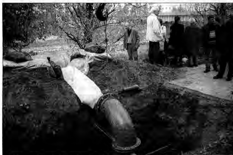
Część magistrali wodociągowej oczyszczona została z 80-letnich osadów.
