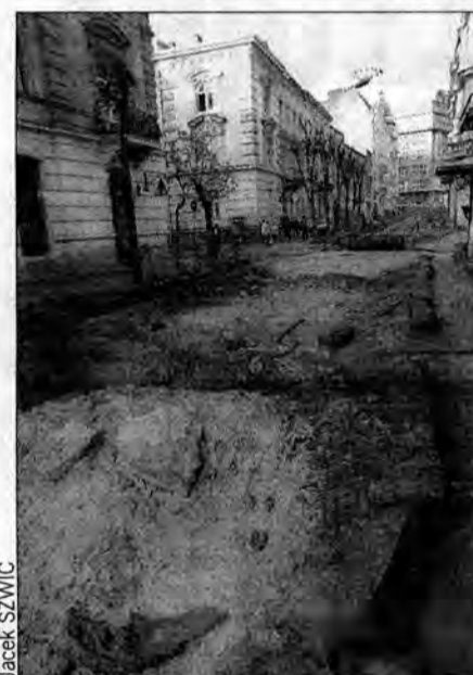
Lwów przed wizytą papieża Jana Pawła II przypomina wielki plac budowy.
