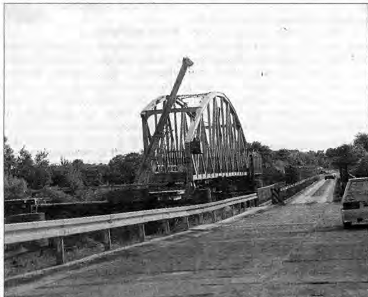
W Radymnie trwają intensywne prace przy przebudowie mostu na Sanie.
