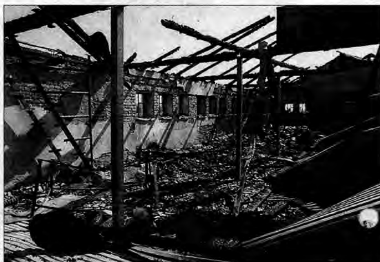
Spalone wnętrze zakładu.
