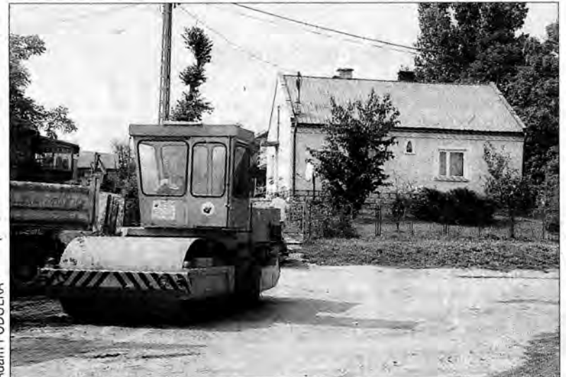
Ciężki sprzęt budowlany przejeżdża codziennie tuż obok domów w Skołoszowie.
