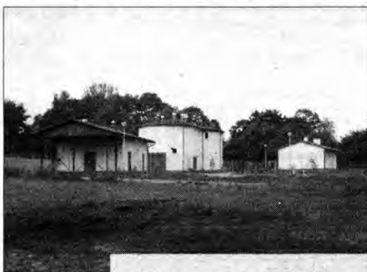
Nad brzegiem Sanu stoją trzy budynki oczyszczalni w Nizinach. Obiekty wyglądają tak samo estetycznie jak wszystkie zabudowania w tej wsi.
