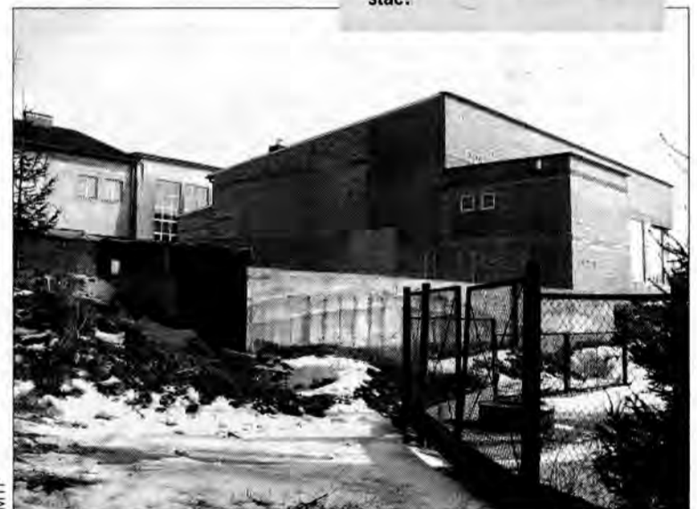
Według planu w tym miejscu ma stanąć 6-piętrowy budynek oświatowy z windą w środku. Pytanie tylko, czy Dynów na to stać?
