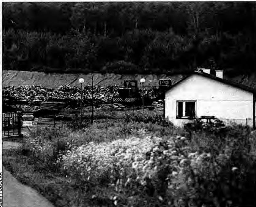
Wysypisko odpadów komunalnych w Młynach.
