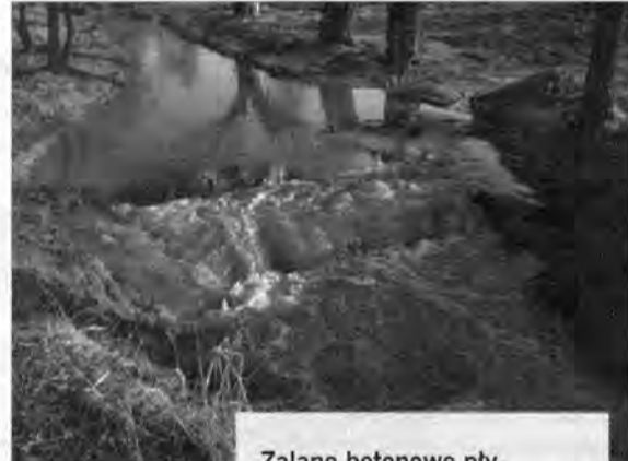
Zalane betonowe płyty, przez które mieszkańcy przechodzili na drugą stronę Dynówki.
