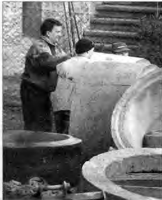
Pracownicy firmy podczas przewracania betonowych kręgów.
