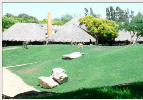
Nawet budynki usługowe i administracyjne nawiązują kształtem do afrykańskiej wioski
