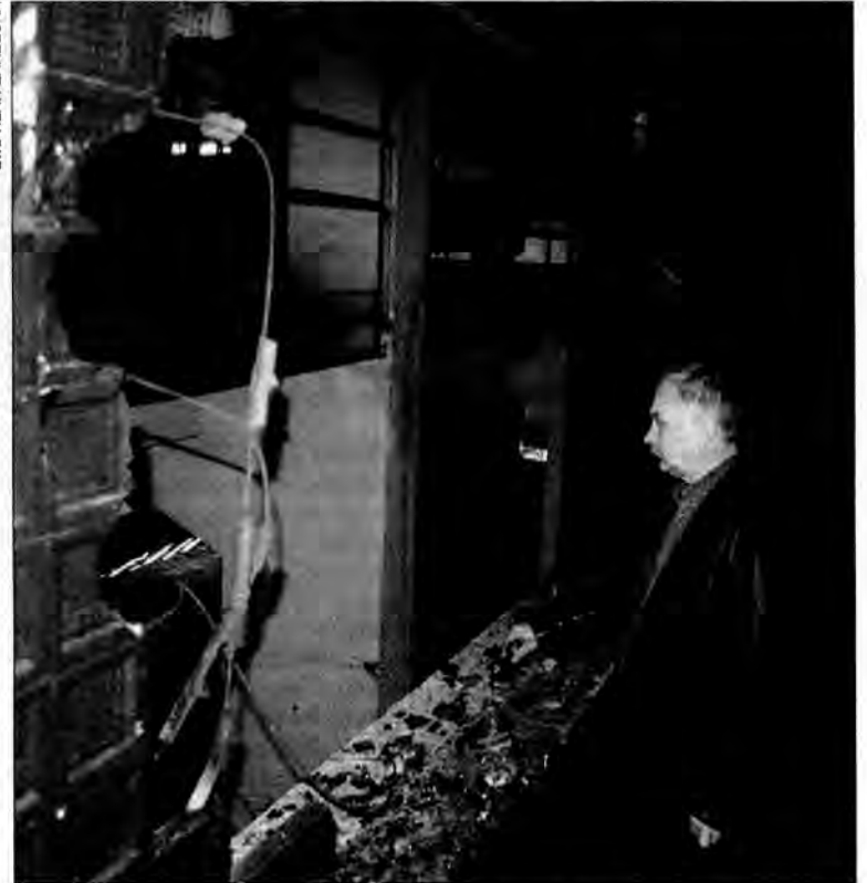
Tak wyglądają wnętrza budynków, które jeszcze kilka lat temu były w bardzo dobrym stanie.
