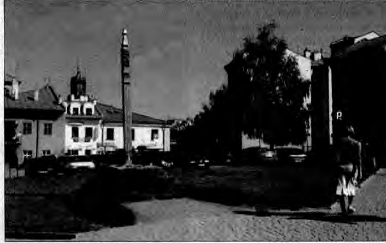
Teren na placu Bóżnic przygotowywany pod parking z 60 miejscami.
