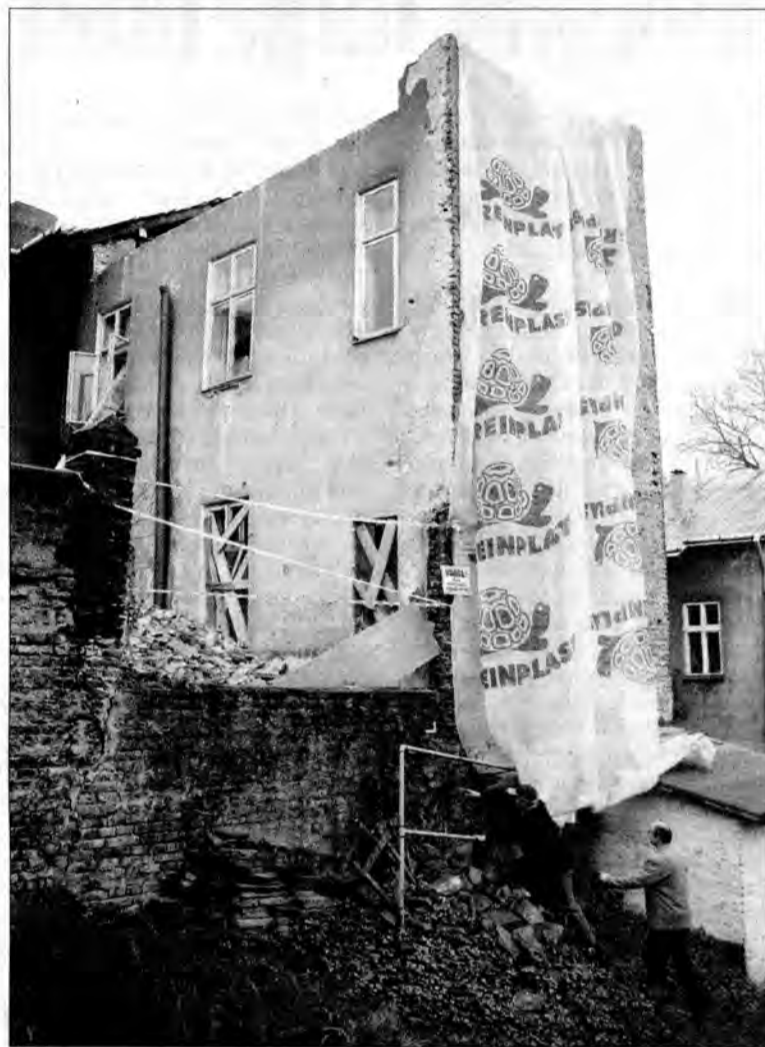
1. Mieszkańcy domów znajdujących się w pobliżu rozbieranego budynku są przerażeni, ponieważ ich zdaniem rozbiórka odbywa się bez jakiegokolwiek zabezpieczenia.
