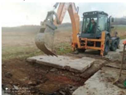
Prace przy drodze gminnej w Rogach
