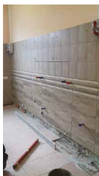
Remont pomieszczeń w Domu Ludowym w Głowience
