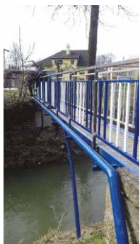
Kładka w Głowience po remoncie
