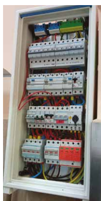
W budynku gminnym w Miejscu Piastowym wymieniono starą tablicę rozdzielczą na nową z wyłącznikami instalacyjnymi
