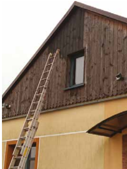
Malowanie Domu Ludowego w Widaczu
