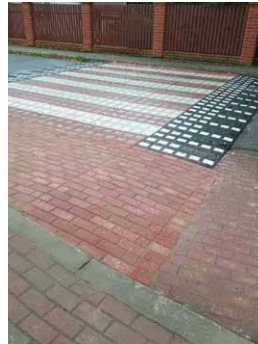
Przejście na ul. Szkolnej w Miejscu Piastowym
