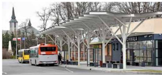
Dworzec autobusowy w Boguchwałce
