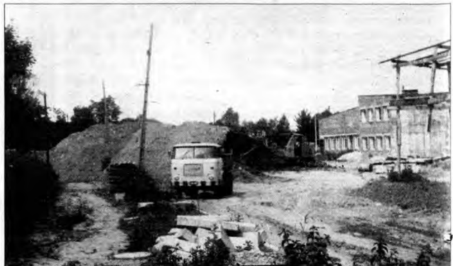
Rozpoczęcie budowy nowej siedziby przy ulicy Lwowskiej w Przemyślu.
