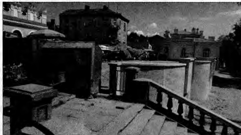
Wykonanie muru oporowego to pierwszy krok do zmiany otoczenia hali targowej, teraz czas na kolejne inwestycje.
