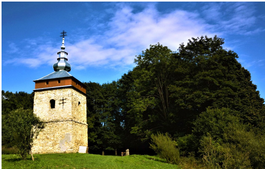
Fot. 6. Polany Surowiczne – dzwonnica po remoncie zakończonym w 2019 r.
