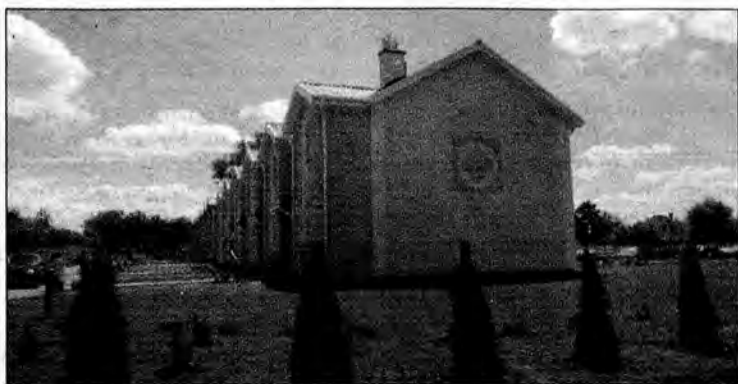
Domy jednorodzinne w zabudowie szeregowej.
