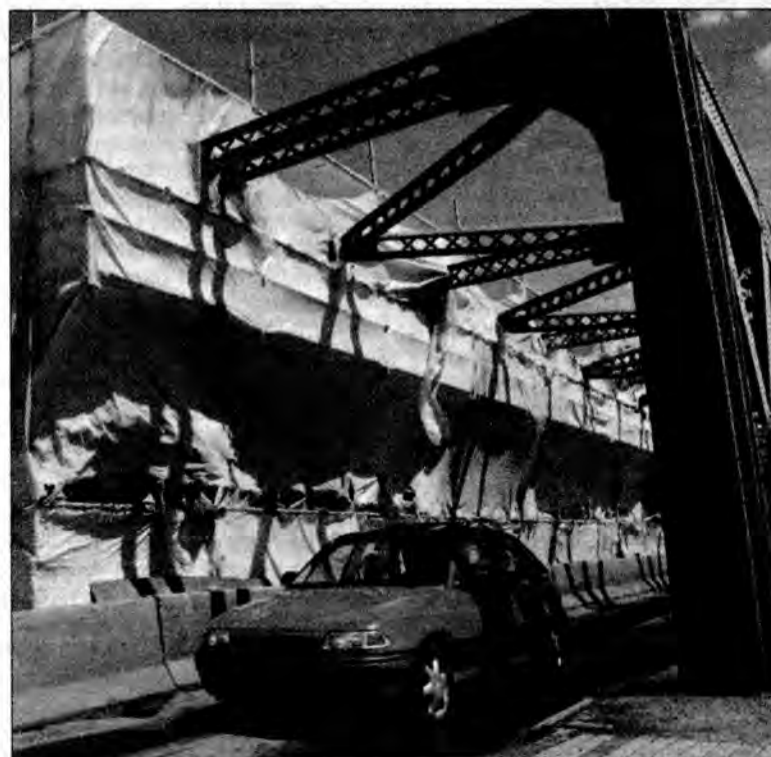
Prace remontowe górnej części mostu na Sanie mogą zakończyć się jeszcze w tym roku.
