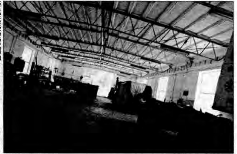
W tym miejscu ma być prowadzona produkcja paliwa alternatywnego.
