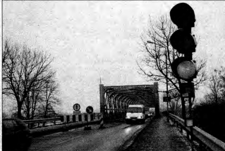
Prace remontowe na moście dobiegają końca. Już na Gwiazdkę mieszkańcy mają jeździć po obu pasach.
