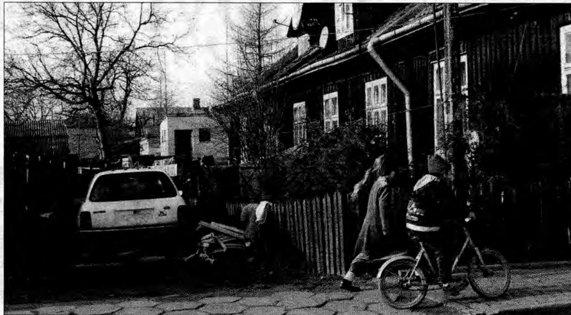
W baraku przy ul. Rybackiej można nadal mieszkać, ale remont jest nieunikniony.
