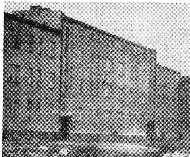
Przed okazałym blokiem duży wykop. Tu miało stawać fundamenty następnego bloku mieszkalnego. Niestety, rozbudowa Osiedla została przerwana.
