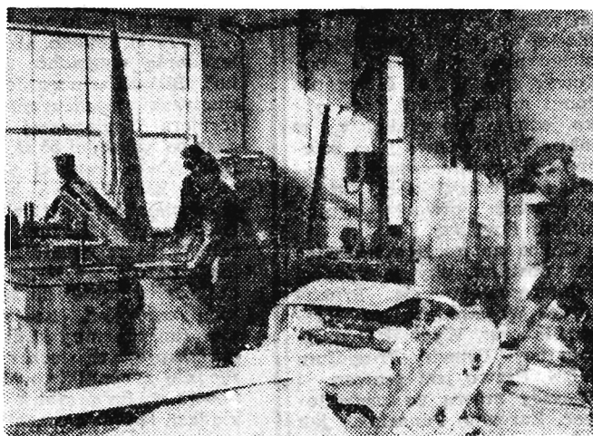
ZRM—WZGS Hala obróbki wiórowej oddziału Stolarni.
