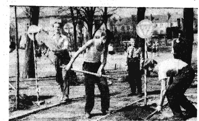
Harczerze z Technikum Samochodowego przy ustawianiu znaków drogowych w Ogródku Jordanowskim. Fot. - Łokaj
