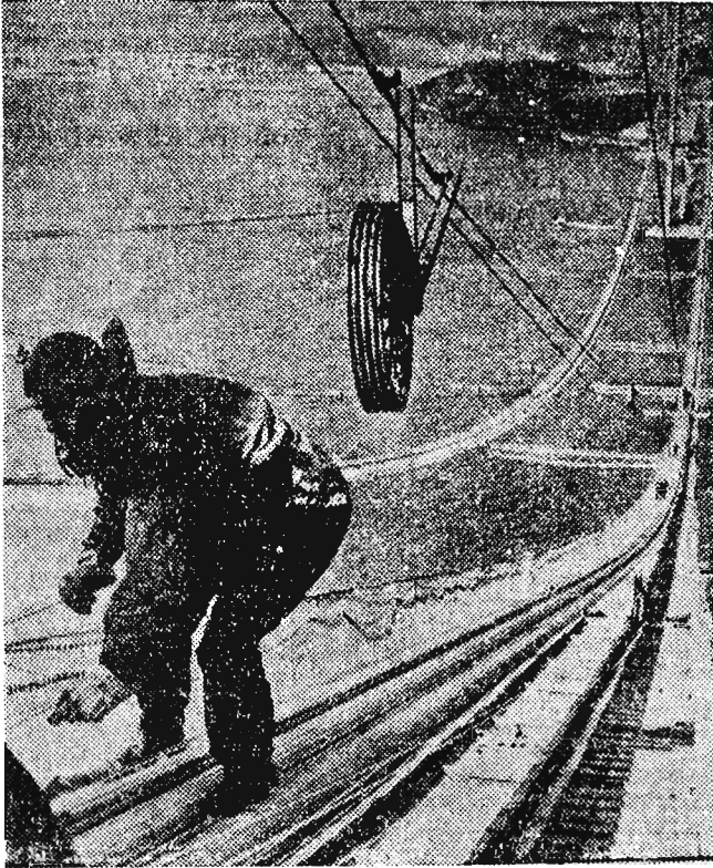
Monter na 990-metrowym prześle mostu wiszącego, który połączy Północną i Południową Queensferry (Szkocja). CAF
